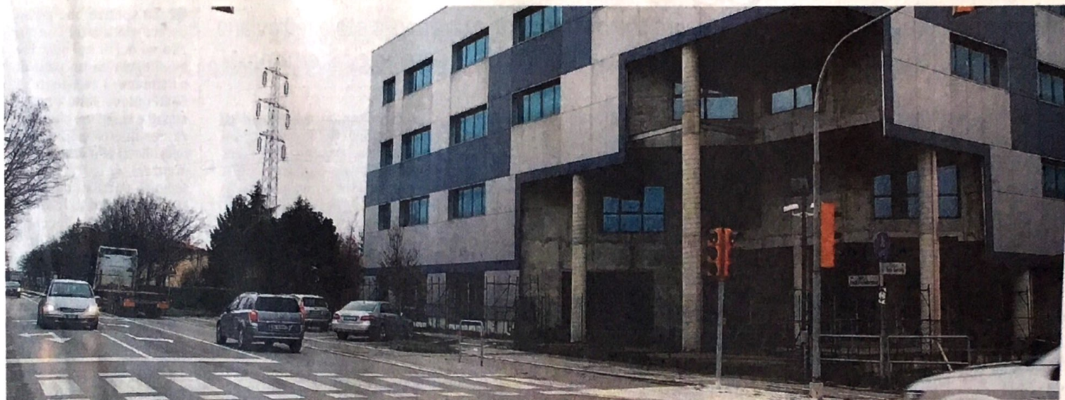
Lo stabile di via Indipendenza mai ultimato e dove l'amministrazione prevede di trasferire il nido di via Dante
